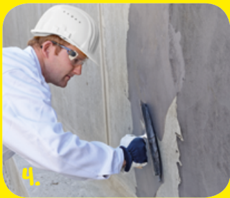
4. Aufbringen der porenfüllenden Kratzspachtelung aus weber.tec Superflex D 24 .
