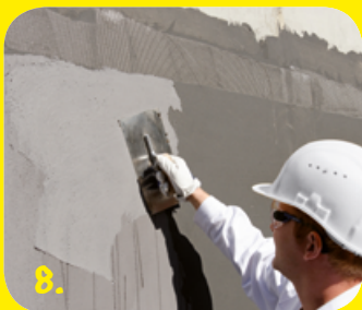
8. Aufbringen der zweiten Abdichtungslage aus weber.tec Superflex D 24 .
