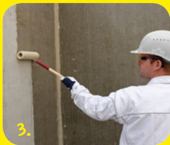
3. Aufbringen der Grundierung aus weber.prim 801 .
