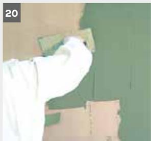
Anschließend wird das Armierungsgewebe in senkrechten oder waagerechten Bahnen mit Glätter oder Traufel faltenfrei in den Armierungsmörtel eingedrückt. Die Gewebekanten müssen an den Stößen mind. 10 cm überlappen (**Abb. 21**). Das Gewebe muss anschließend in der oberen Hälfte des Armierungsmörtels liegen (alternative Gewebe siehe Tabelle).
