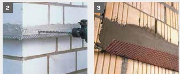
Von vorne kommt wiederum ein Panzereckwinkel auf die Dämmplatten, so dass die unteren Platten U-förmig von Panzereckwinkeln umfasst werden. Bei angeklebten oder vermörtelten Klinkerriemchen, die tragfähig sind, sollte nicht gedübelt werden, da sich sonst die Riemchen lösen können.
