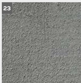
Hierbei darf weder das Gewebe freigelegt werden, noch darf eine Sinterhaut an der Oberfläche entstehen (**Abb. 23**). Zwischen Armierungsmörtel und Fensterbank muss eine Trennung ausgeführt werden. Angrenzende Bauteile sind vom Putzsystem zu trennen.
