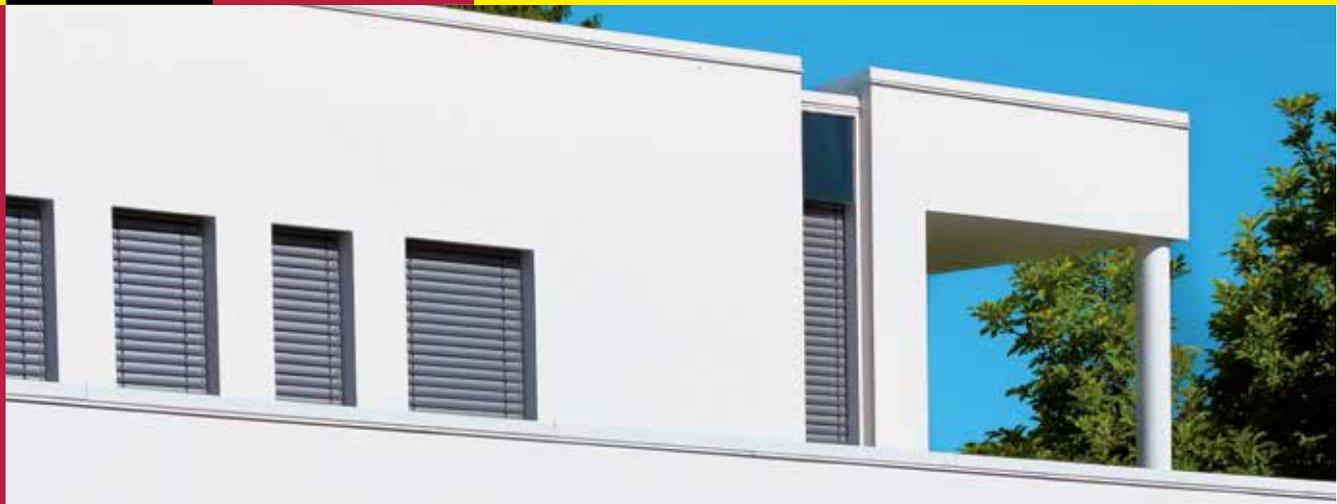
WDVS mit Hochleistungs-Dämmplatten aus Resol-Hartschaum und dickschichtigem Putzaufbau
