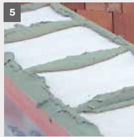
Der Mörtel kann mit allen üblichen Putzmaschinen verarbeitet werden. Für das Aufbringen des Klebemörtels auf die Dämmplatten kann eine spezielle Klebepistole z.B. PFT oder Putzmeister eingesetzt werden. Die Dämmplatten **weber.therm RS 021 plus ultra** werden rahnenförmig an den Plattenrändern mit drei senkrechten Streifen mit Klebemörtel beschichtet (**Abb. 5**).
