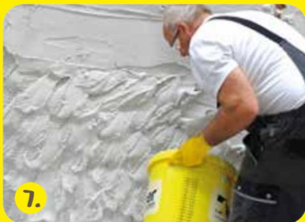
Frisch in frisch Sanierputz einlagig in Schichtdicken bis max. 40 mm aufbringen
