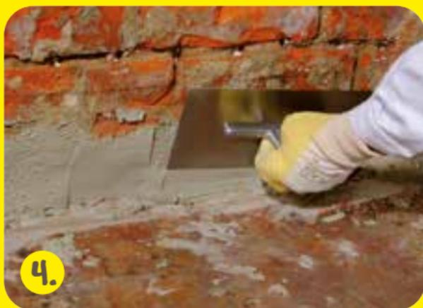
Haftschlämme aus **weber.tec 933** am Boden/-Wandanschluß auftragen und mit **weber.tec 933 Kehlvernetzung** einbringen
