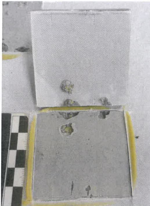
Bild 1: Bruchbild der Haftzugprüfung Nr. 9 an der Probe FL 3 (untere Gewebelage)
