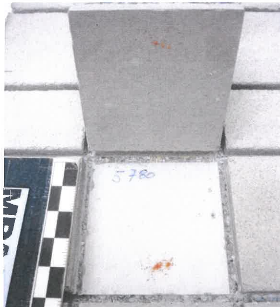
Bild 5: Exemplarisches Bruchbild der Haftzugprüfung Nr. 1 des Prüfkörpers FB 2
