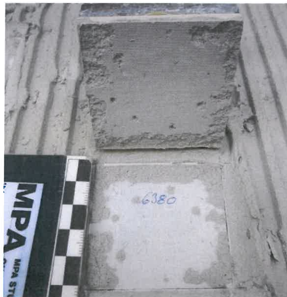
Bild 3: Exemplarisches Bruchbild der Haftzugprüfung Nr. 7 des Prüfkörpers FL 2
