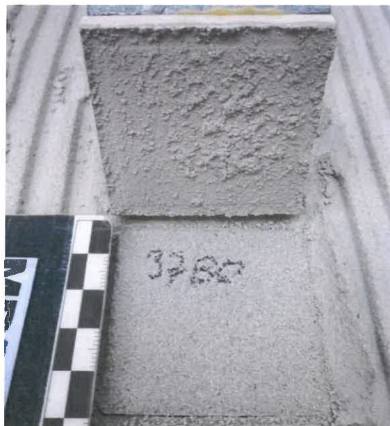
Bild 2: Exemplarisches Bruchbild der Haftzugprüfung Nr. 9 des Prüfkörpers FL 1
