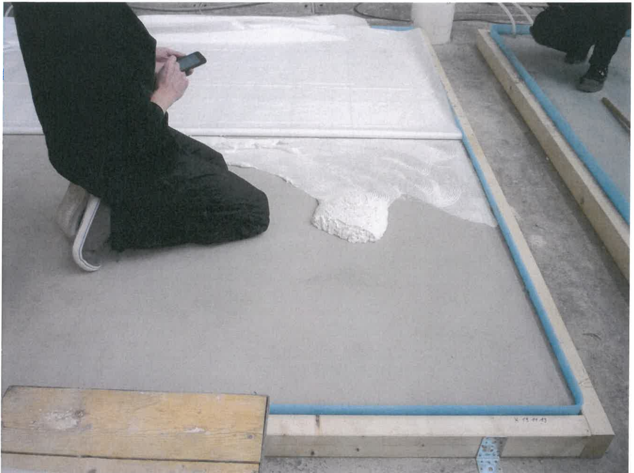
Bild 3: Verkleben des Kiesel Okalift SuperChange Gewebes auf den Estrichflächen
