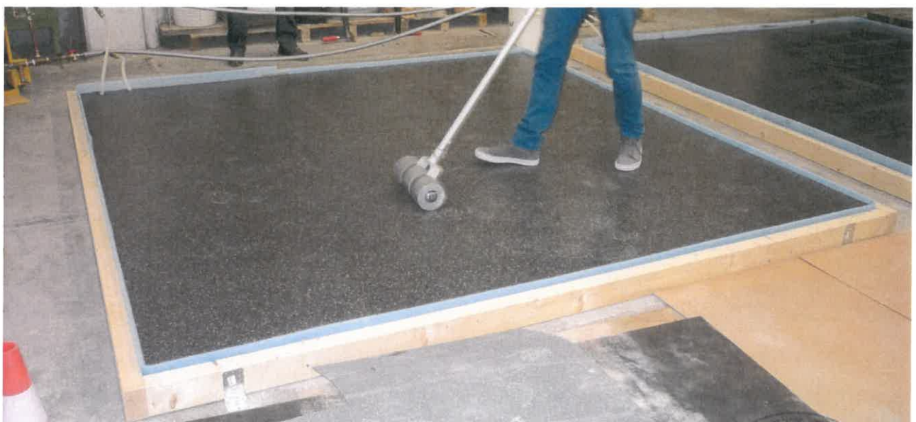
Bild 4: Fertige Musterbodenflächen (links mit Gummibelag, rechts mit Feinsteinzeugfliesen)
