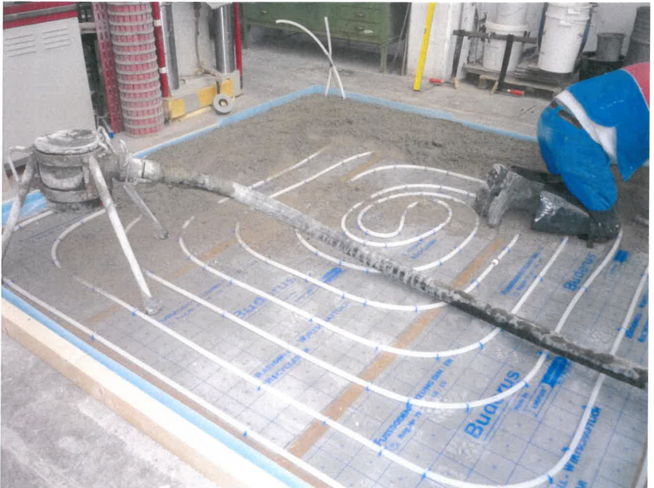
Bild 2: Einbau des Estrichs durch eine Fachfirma
