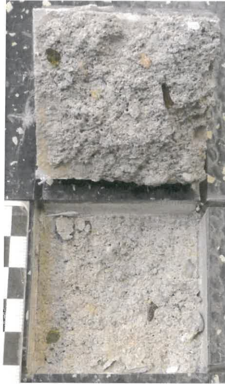
Bild 3: Bruchbild der Haftzugprüfung Nr. 2 bei der Prüfung der Haftzugfestigkeit zwischen unterer Gewebelage der Bodenkonstruktion mit Bodenbelag (Gummibelag) und Untergrund
