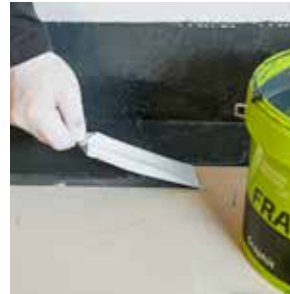
Klebeband oben und unten entfernen
