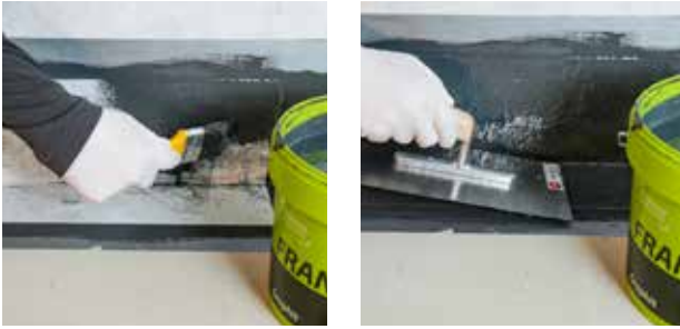
Auftrag der 2. Lage entweder mit Pinsel... oder mit Aufstreichkelle
