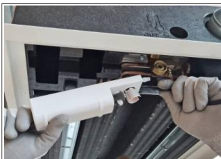
Abb. 43: Kondensatpumpe demontieren
