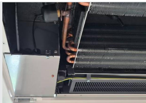
Position Elektroanschlussbox (bei abgenommener Kondensatwanne)
