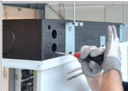
Abb. 16: Anschlusslöcher öffnen
