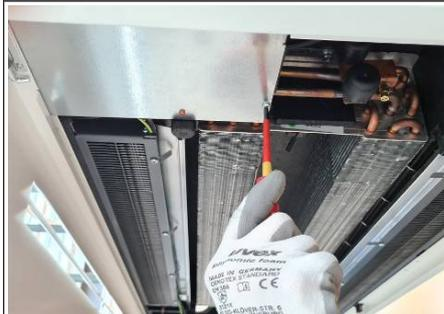
Abb. 20: Elektroanschlusskasten öffnen
