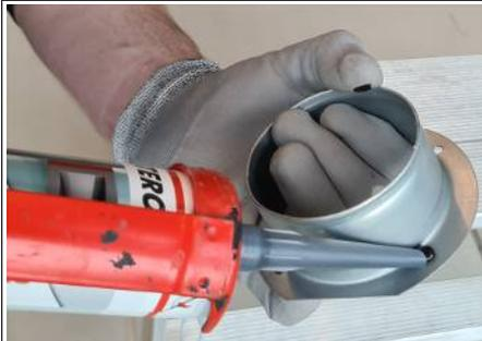
Abb. 24: Primärluftanschlusstutzen abdichten
