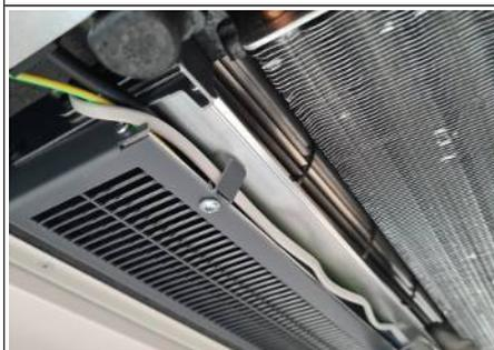
Abb. 19: Kabel Stellantrieb verlegen
