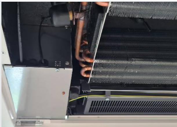
Position Elektroanschlussbox (bei abgenommener Kondensatwanne)
