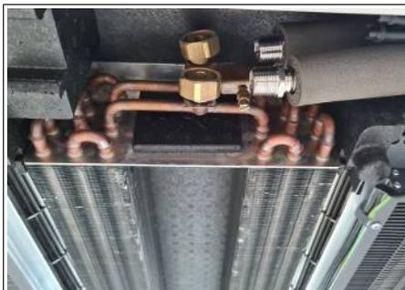
Abb. 18: Isolierung bis zum Gewinde
