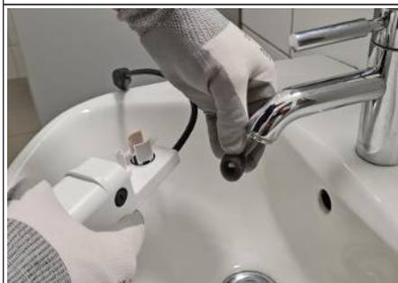
Abb. 45: Schmutzfilter reinigen
