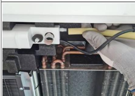
Abb. 21: Kondensatschlauch an Kondensatpumpe befestigen
