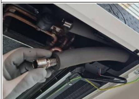
Abb. 17: Flexible Wellrohre
