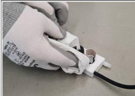
Abb. 44: Kondensatpumpe reinigen
