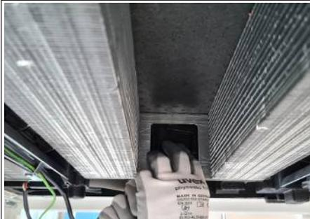
Abb. 25: Primärluftabdeckung entfernen
