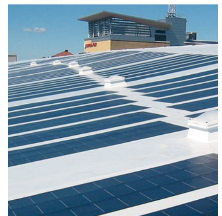
Dachintegration mit der weltweit ersten Solar-Dachbahn EVALON® Solar
