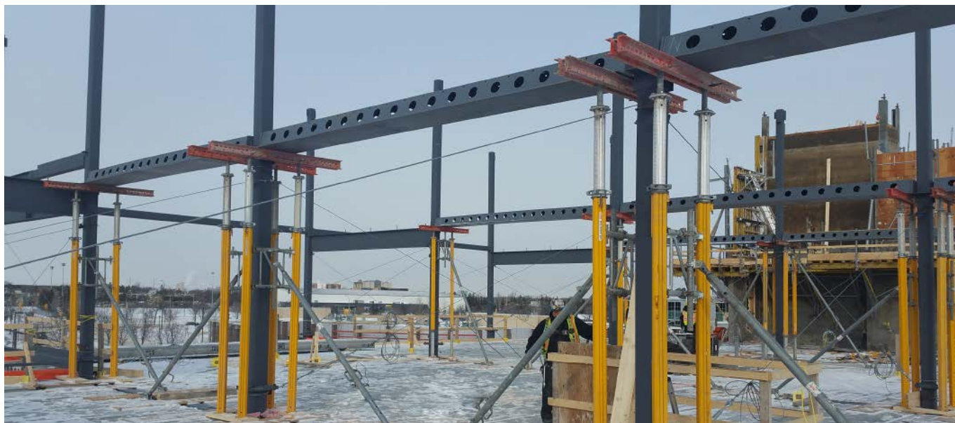
Abbildung 6. Abstützung des DELTABEAM®
