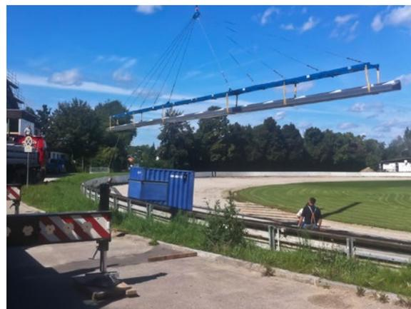
Eine Krantraverse für Bahnlängen von bis zu 30 m inklusive festem Kranhaken ohne Gurte, Eigengewicht 980 kg, zuzüglich Nutzlast max. 1500 kg wird bei Bedarf in halbfertig vormontiertem Zustand beige stellt. Weitere Spezialtraversen sind auf Anfrage erhältlich.
