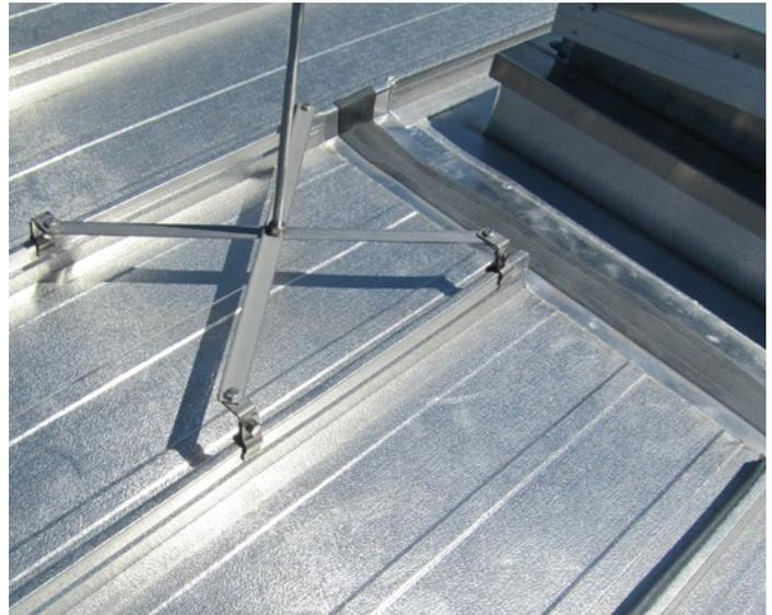
Eingeschweißte Lichtkuppel mit Dilatationsband; Blitzschutz auf Leitungshalter
