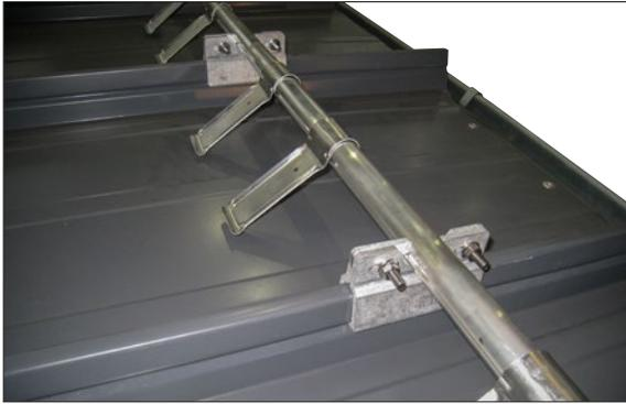
Schneefangvorrichtungen werden mit systemeigenen Klemmlaschen ohne Perforierung der Profilbahnen auf deren Rippen befestigt. Sie stoppen den Schub des auf dem Dach liegenden Schnees und verhindern ein mögliches Herabfallen.
