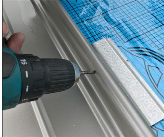
2. Bohrung seitlich im Winkel von etwa 45° am kreisrunden Falz ansetzen
