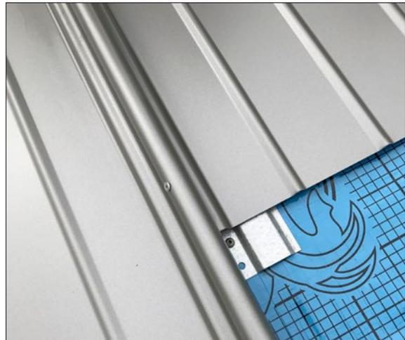
4. Folgeprofilbahn anschließend einschwenken
