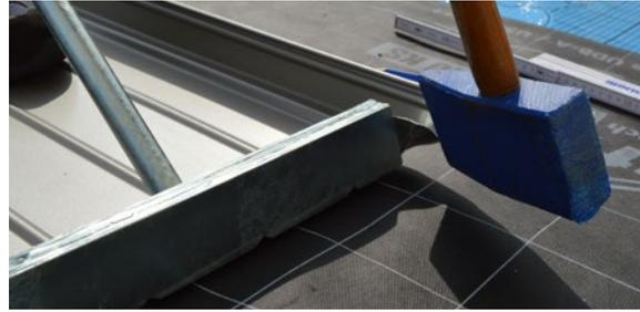
6. Untergurt bis 90° aufstellen und anschließend Baubreite kontrollieren.
