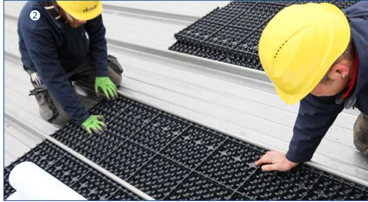
Urbanscape Drainage-System mit Wasserspeicher auf die RIB-ROOF Bahn legen. Darauf achten, dass Ränder unter dem Profilbahnsteg liegen.
