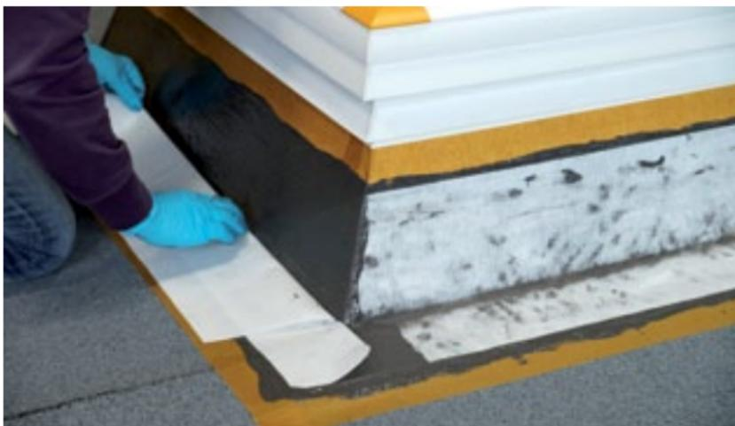
3. PROFI-DICHT-Spezialvlies einlegen, den Eckbereich so einschneiden, dass es sich blasenfrei anschmiegt
