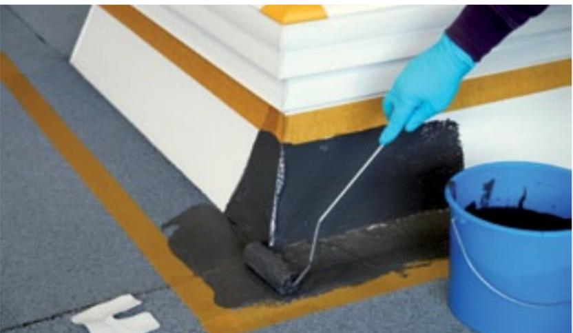
2. Die verarbeitungsfertige PROFI-DICHT-Mischung, mind.  $2,0 \text{ kg/m}^2$ , mit einer Fellrolle satt auftragen und gleichmäßig verteilen
