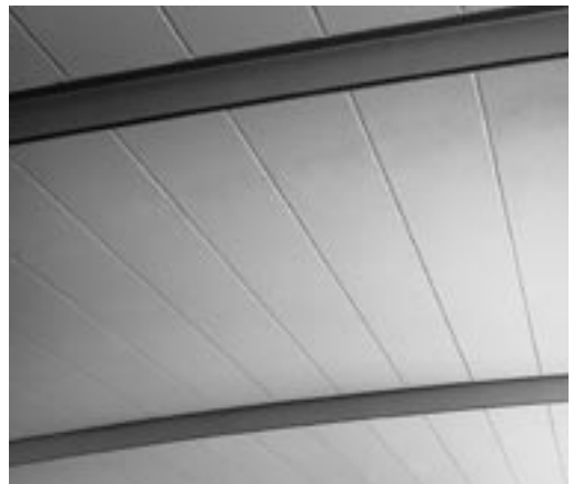
Innenansicht eines HEBEL Daches.
