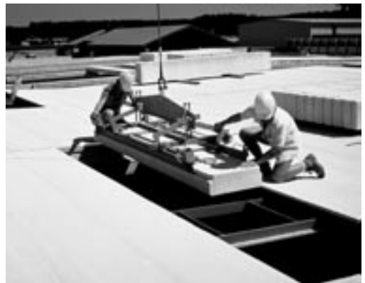
Verlegen von HEBEL Dachplatten mit der Verlegezange.
