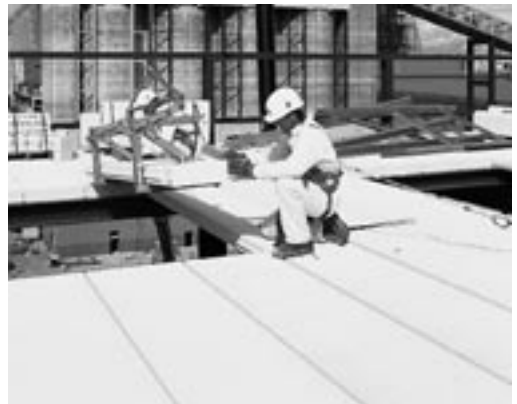
Verlegen von HEBEL Dachplatten mit Verlegebügel.
