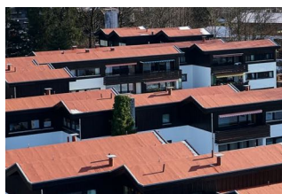
Wohnanlage Oberland, Rhepanol hfk, Dachfläche: 3.300 m 2
