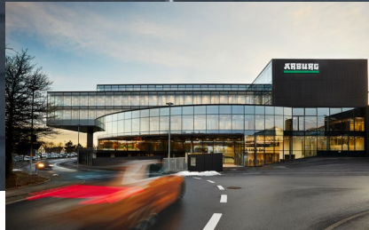
Arburg Schulungszentrum, Loßburg
