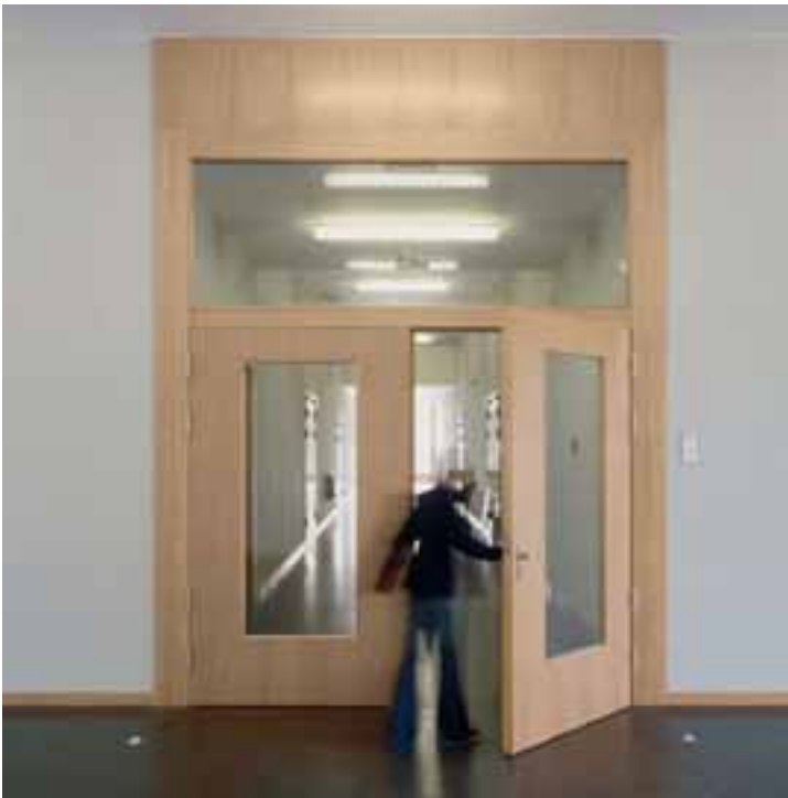
Für das Oberstufen Zentrum in Berlin fertigten wir dieses T90-Element mit einer Abmessung von 3,20m Breite auf 3,60m Höhe
