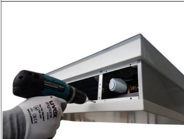
Abb. 11: Verkleidung mit Schrauben befestigen
