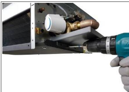
Abb. 74: Ventilkondensatwanne (Deckenausführung) demontieren
