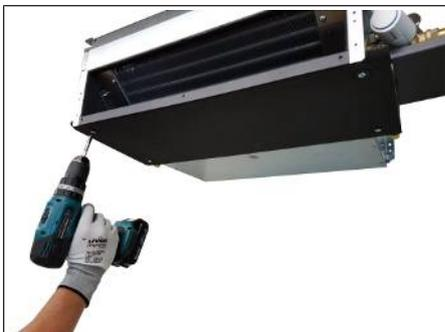
Abb. 70: Hauptkondensatwanne (Ausführung Decke) demontieren
