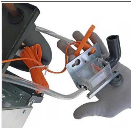
Abb. 77: Schwimmerschalter reinigen.
