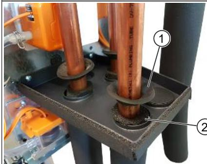
Abb. 32: Gummirohrmanschetten mit Isolierung verkleben
