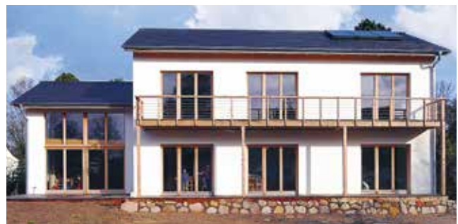
Das laut ÖKO-TEST-Magazin gesündeste Haus Deutschlands steht in Hamburg. Das nach dem Sentinel-Haus-Konzept errichtete Gebäude wurde mit Holzfaserdämmung von PAVATEX umgesetzt.
