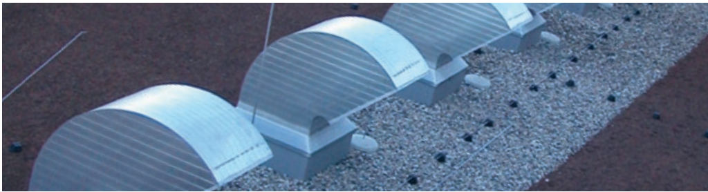
BMW AG, Regensburg. Gebäude sicher abgedichtet mit Rhenofol.
