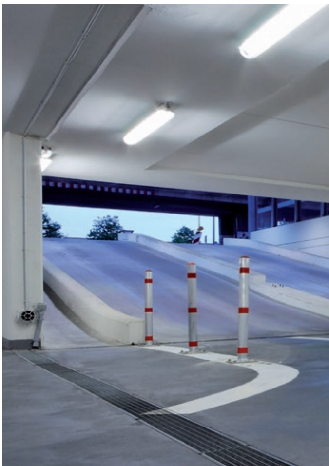
Tiefgarage auch ein Einsatzort für Rhenofol CG.
