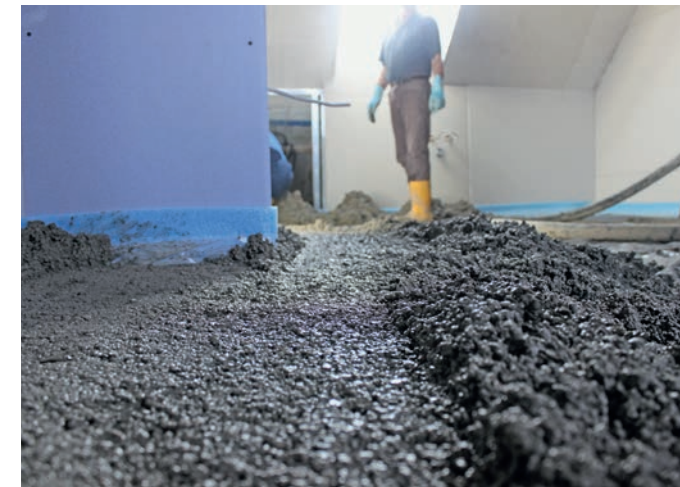
HÖHEN AUSGLEICH VON 9 CM Objekt Dachgeschossausbau, Würzburg
