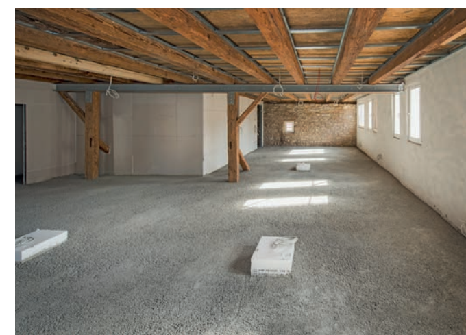
NIVEAU AUSGLEICH BEI UNTERSCHIEDLICHEN HÖHEN Objekt Huchler Scheune, Waiblingen
