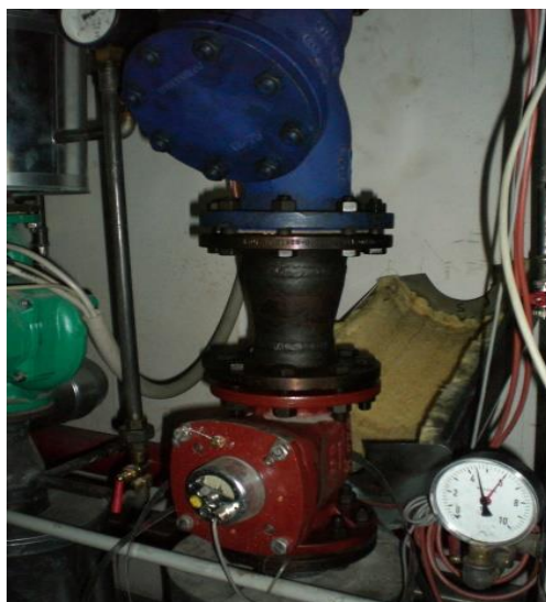
Abbildung 3: Woltmanzähler für Rechenwerk Nr. xxx ohne Beruhigungsstrecken
