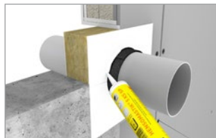
Verschließen des Ringspalts mit HENSOMASTIK® 5 KS SP
