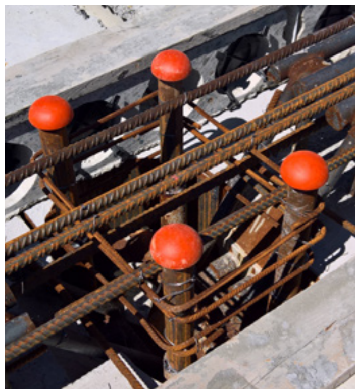
Anschlussbewehrungen für zukünftige Erweiterung der Geschosse.
