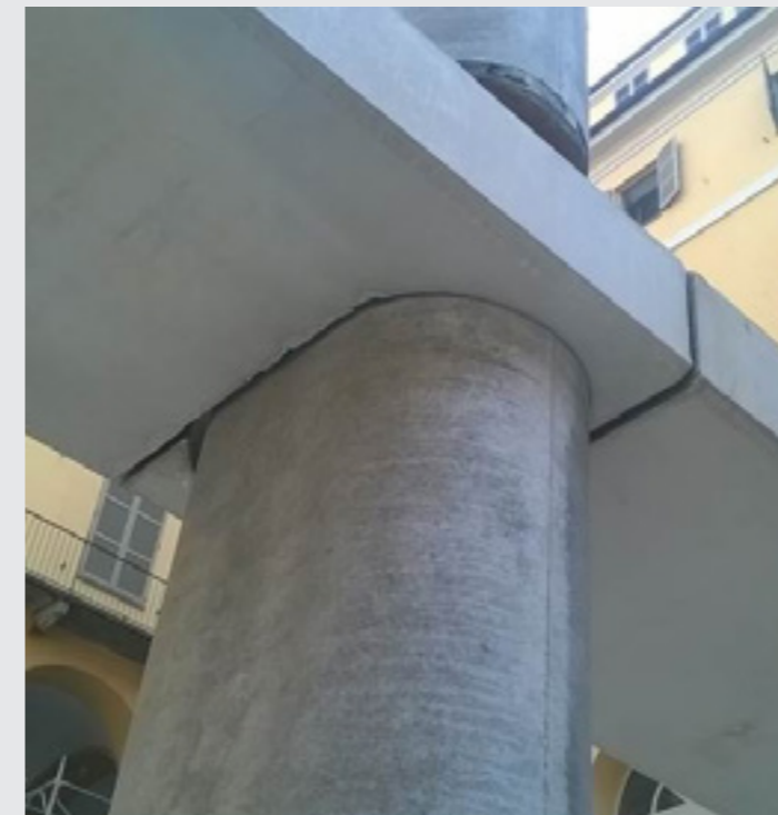
Λ NPS® CLS Träger in Kombination mit PDTI® Stützen ermöglichen das Aufliegen von 14 Meter Langen Spannbetondecken. v NPS® CLS kann sich nahtlos an die ovale Form der PTC® Stütze anpassen.
