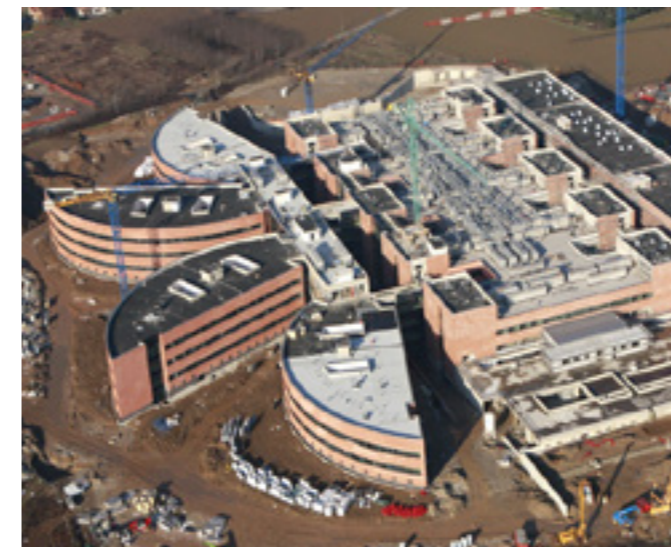
Bau von 16.000 m 2 Einrüstung in 6 Monaten
