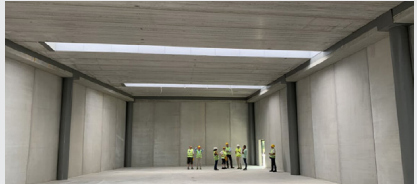
Λ NPS® CLS Träger in Kombination mit PDTI® Stützen ermöglichen das Aufliegen von 14 Meter Langen Spannbetondecken. v NPS® CLS kann sich nahtlos an die ovale Form der PTC® Stütze anpassen.
