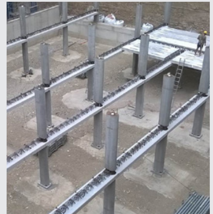
Λ NPS® CLS Träger in Kombination mit PDTI® Stützen ermöglichen das Aufliegen von 14 Meter Langen Spannbetondecken. v NPS® CLS kann sich nahtlos an die ovale Form der PTC® Stütze anpassen.
