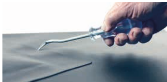
Kontrolle mit Prüfnadel
