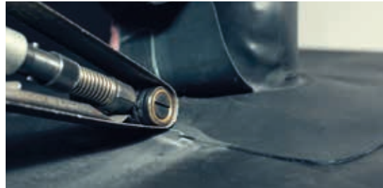
Abschleifen Überlappungsstoß
