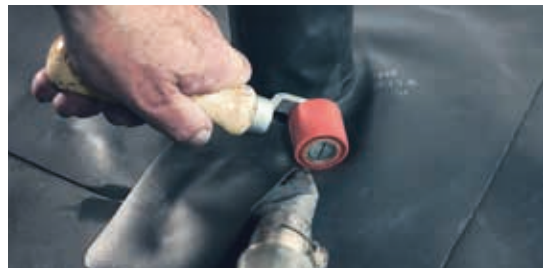
Verschweißen Überlappungsstoß
