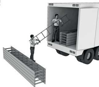
Bild 1 Entladen der Kabeltrassen
