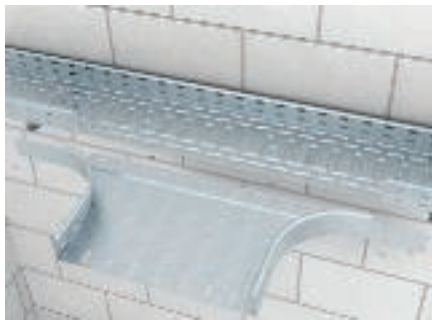
Montage Anbau-Abzweigstück (Breite 400 - 600 mm)
