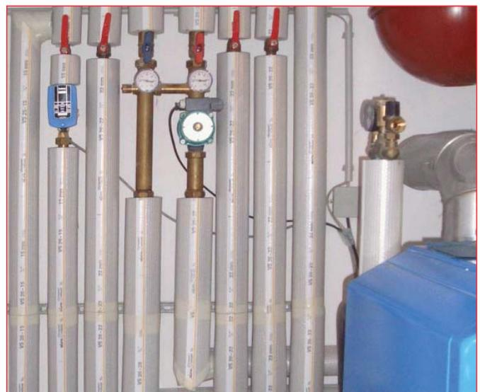
■ **Bild 4 Mit Misselon-Robust gedämmte Rohrleitungen** – Weiteres Verbesserungspotenzial: Dämmung der Armaturen und Fittings mit Missel Armaturendämmungen bzw. Missel Dämmfittings, siehe Bild 5 und Abschnitt 9, Seite 26
