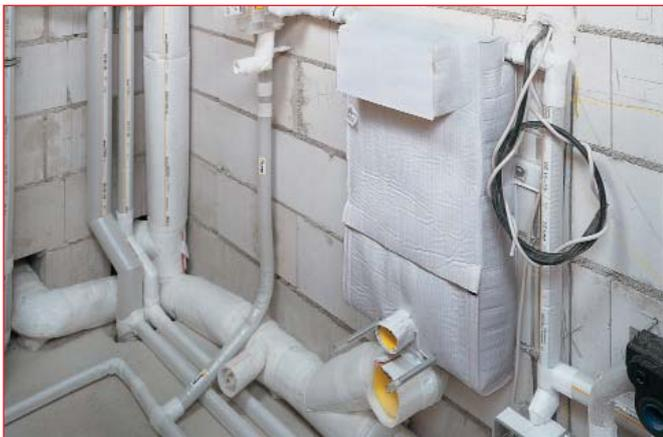
■ **Bild 6a** Dämmung von TWK mit Misselfix-Garant (Schläuche und Formteile) sowie Dämmung von weiteren Rohrleitungen und Sanitärelementen
