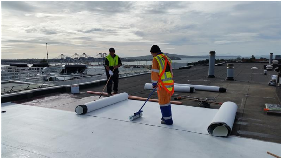
Bild 3: Dichtungsbahn MAPEPLAN T Af auf frei bewitterter Dachfläche
