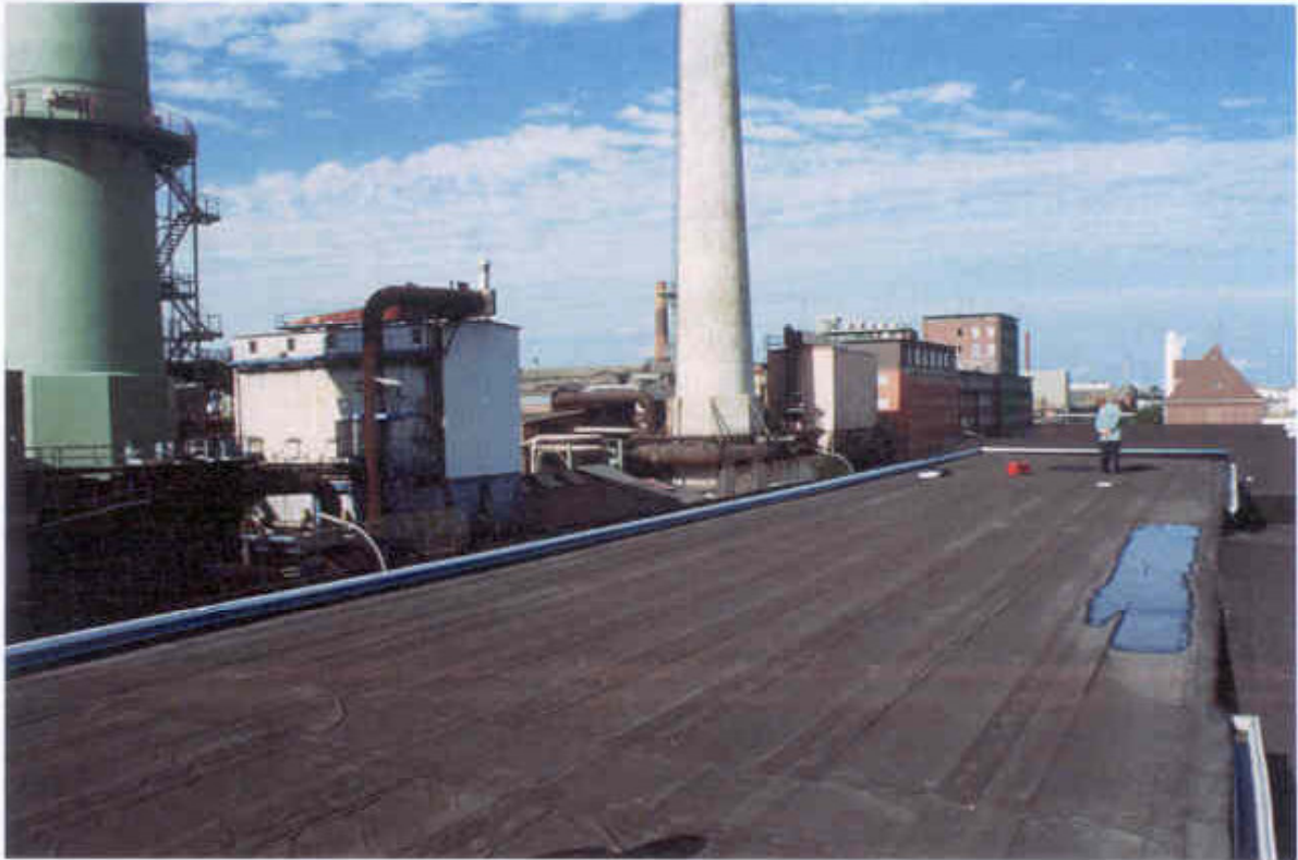
Bild 1: Begutachtung der Dachfläche des BV „HH-Veddel, Industriegebäude“
