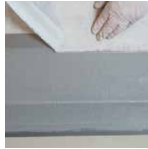
Klebeband oben und unten entfernen
