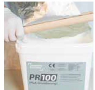
6. Knetbeutel mit Hilfe des Beutelentleeres restlos in ein sauberes Gebinde entleeren.
