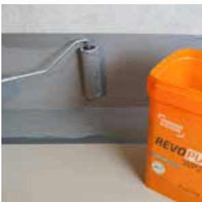
Ca. 1/2 -2/3 der vorgegebenen Menge Abdichtung in gleichmäßigen Schichtdicken aufbringen.
