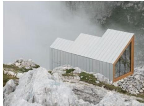
öko skin flex 147 mm, verschiedene Farben, vertikale Verlegung, genietet auf Aluminium-Unterkonstruktion
