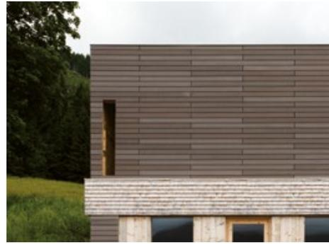
öko skin 147 mm, silbergrau, vertikale Verlegung (1/3 versetzt), geschraubt auf Holz-Unterkonstruktion
