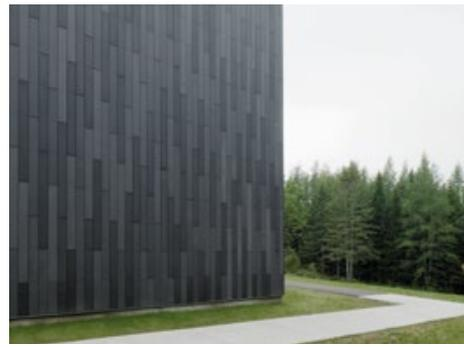
öko skin flex 125 mm, verschiedene Farben, vertikale Verlegung, geschraubt auf Holz-Unterkonstruktion
