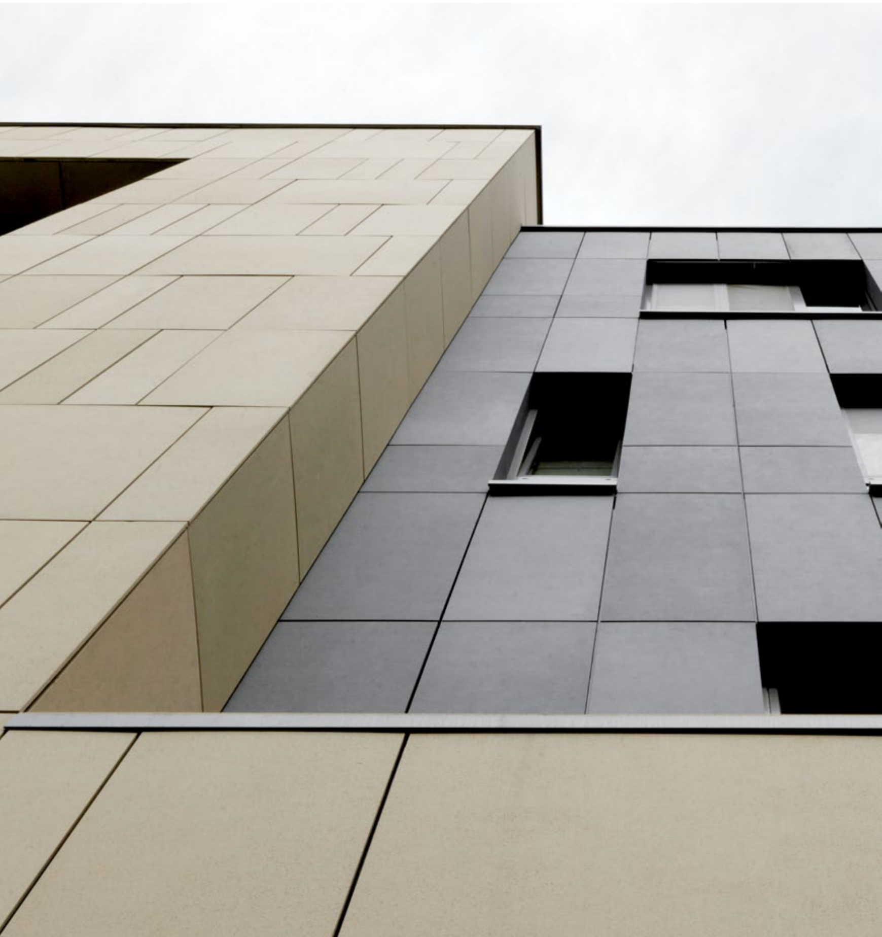
Buddhist Center Vienna, AT | HOPPE Architects Vienna, AT | 800 m 2 fibreC facade | silvergrey & sandstone | FE | adhesive Buddhistisches Zentrum Wien, AT | HOPPE Architekten Wien, AT | 800 m 2 fibreC Fassade | silbergrau & sandstein | FE | geklebt
