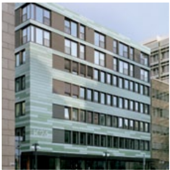
Office Building K24 Stuttgart, DE | Willwersch Architects Stuttgart, DE | 450 m 2 fibreC facade | green | FE & MA | riveted Bürogebäude K24 Stuttgart, DE | Willwersch Architekten Stuttgart, DE | 450 m 2 fibreC Fassade | grün | FE & MA | genietet
