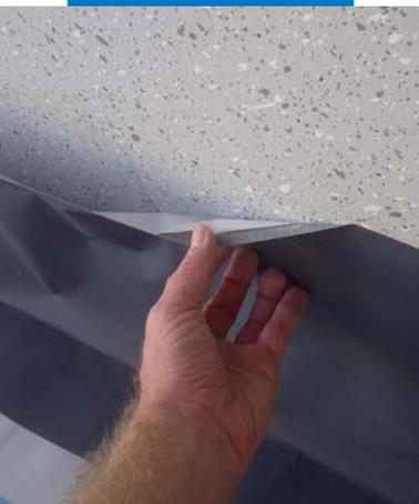
Senkrechten Anschluss auf der notwendigen Höhe durch stellenweises Ablösen der Abziehfolie anheften (mind. OK Wärmedämmung bzw. Dämmstoffkeil).
