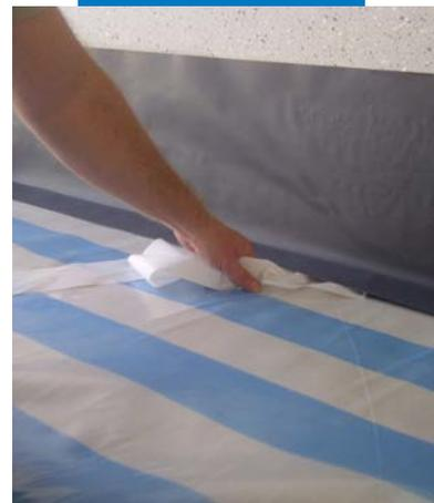
**Mapeplan VAP Tape in der Fläche durch abziehen der rückseitigen Trennfolie (10 cm) mit der Dampfsperre verkleben und leicht andrücken.**
