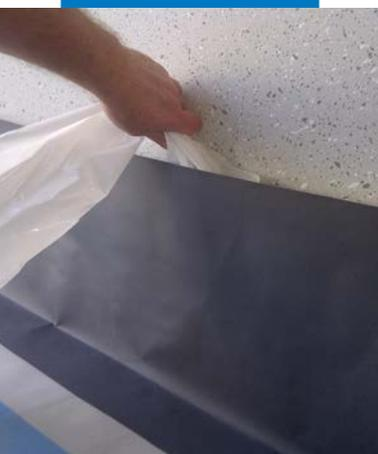
Mapeplan VAP Tape im senkrechten Anschlussbereich durch abziehen der rückseitigen Trennfolie (20 cm) verkleben.
